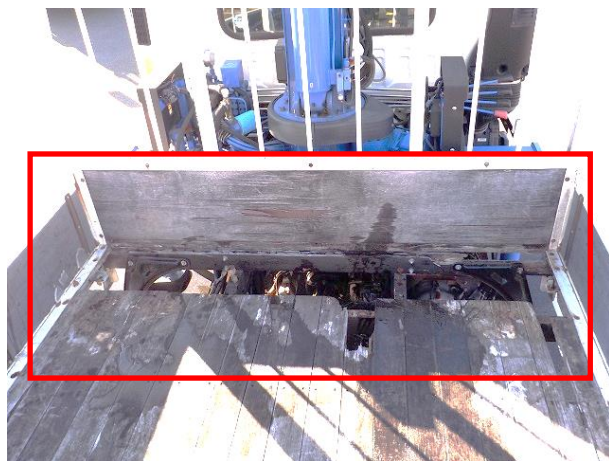
荷台損傷状況
