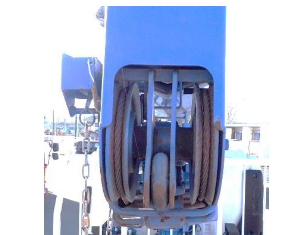
クレーンワイヤー状況
